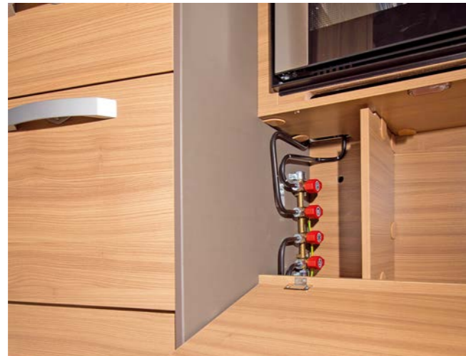
De gaskranen bevinden zich onder de oven.
