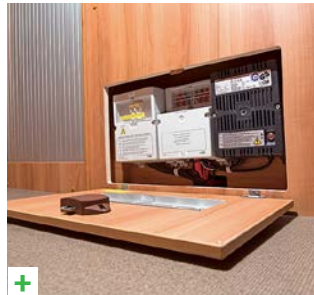
+ Goed toegankelijke en beschermde elektracentrale in de zitbank.
